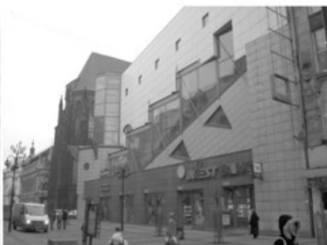
Dom towarowy we Wrocławiu przy ul. Świdnickiej obok kościoła św. Doroty, 1993 r.
